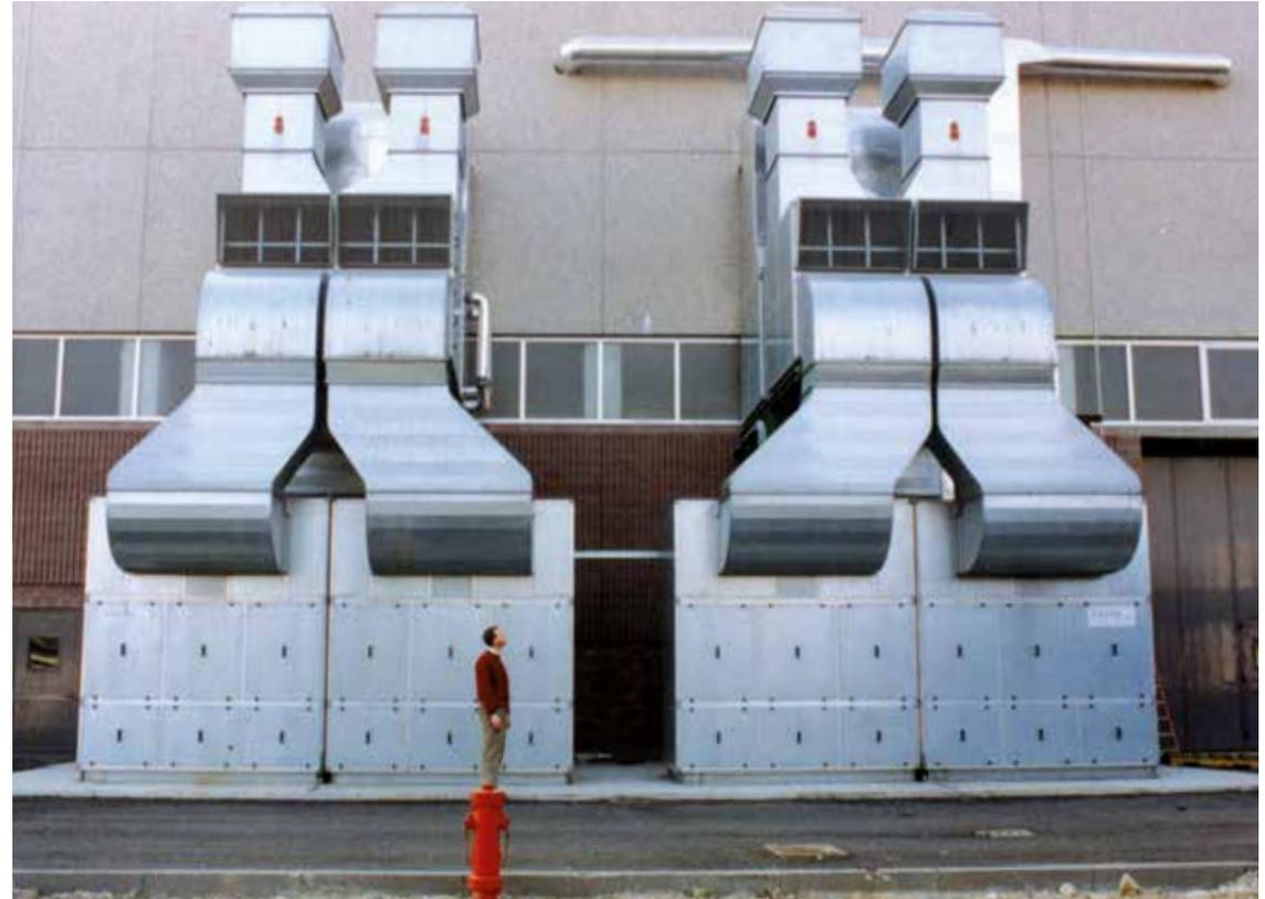
Устройства аспирации, фильтрации, рекуперации тепла и нагрева воздуха с подачей горячей воды.
