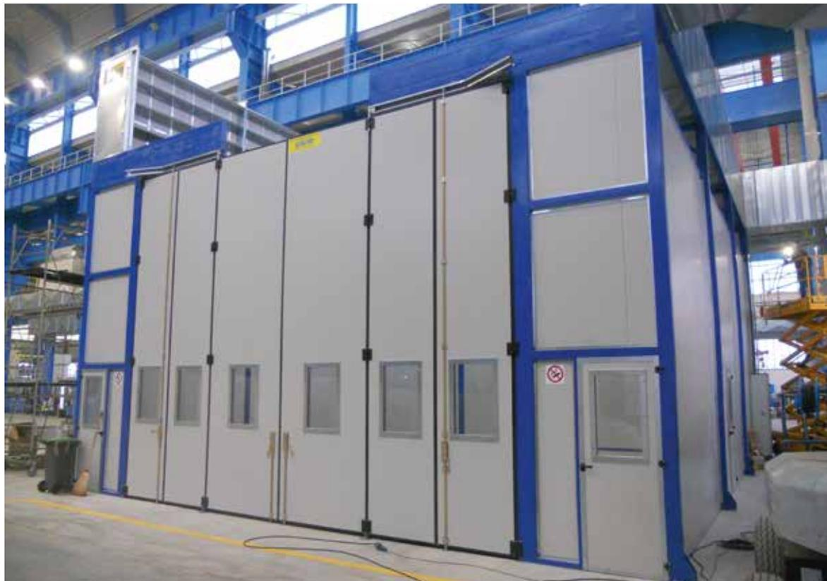
Камера промышленной покраски в комплекте с узлами вентиляции и нагрева прямого обмена.
